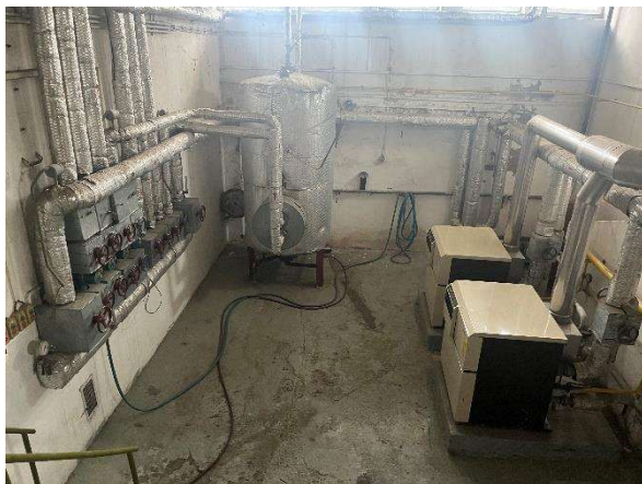
Obrázek 8 Současný zdroj tepla pro objekt – plynová kotlina
